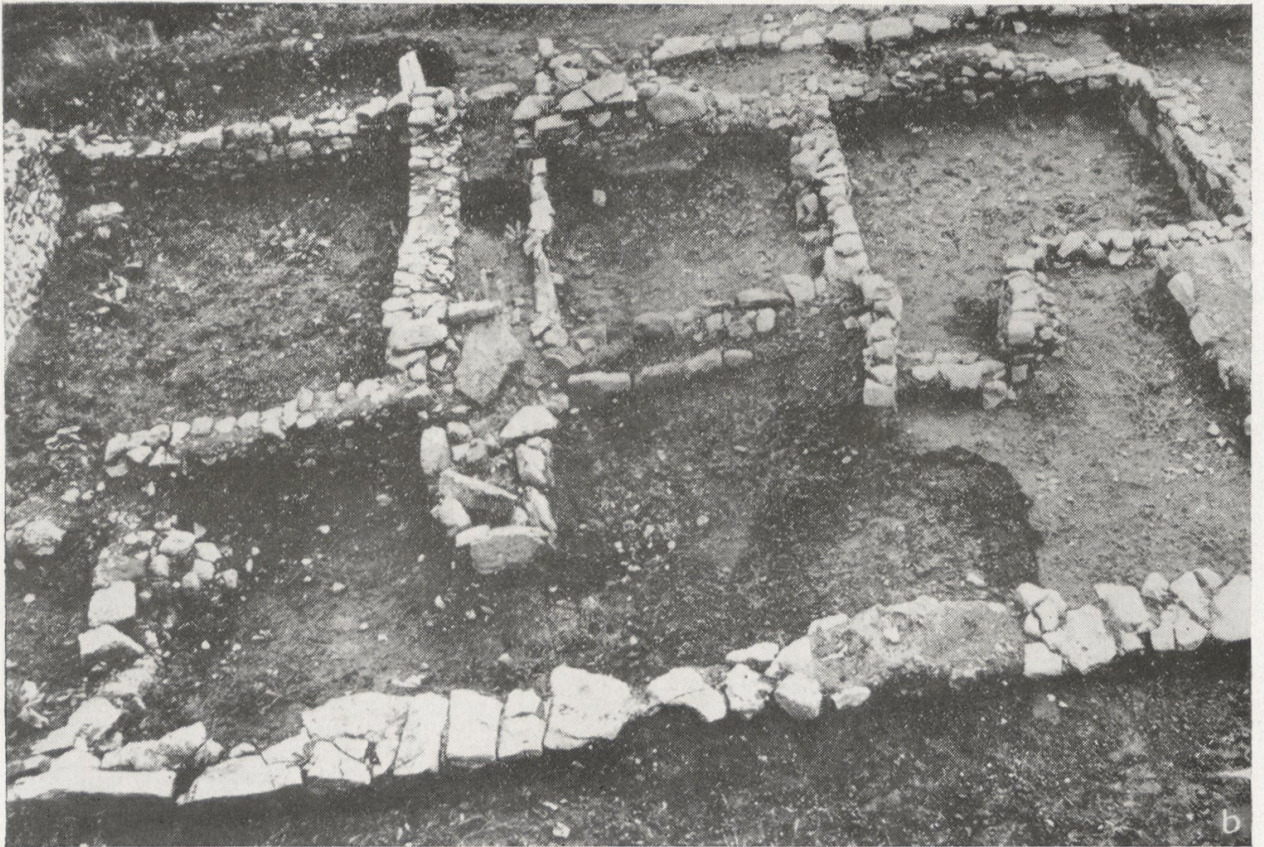
Tilleda, Kr. Sangerhausen. a) Freistehende Ofenanlage von der Halle an der Nordostecke; b) Gebäudeteil mit eingebauter Heißluftanlage an der Südseite der Hauptburg
