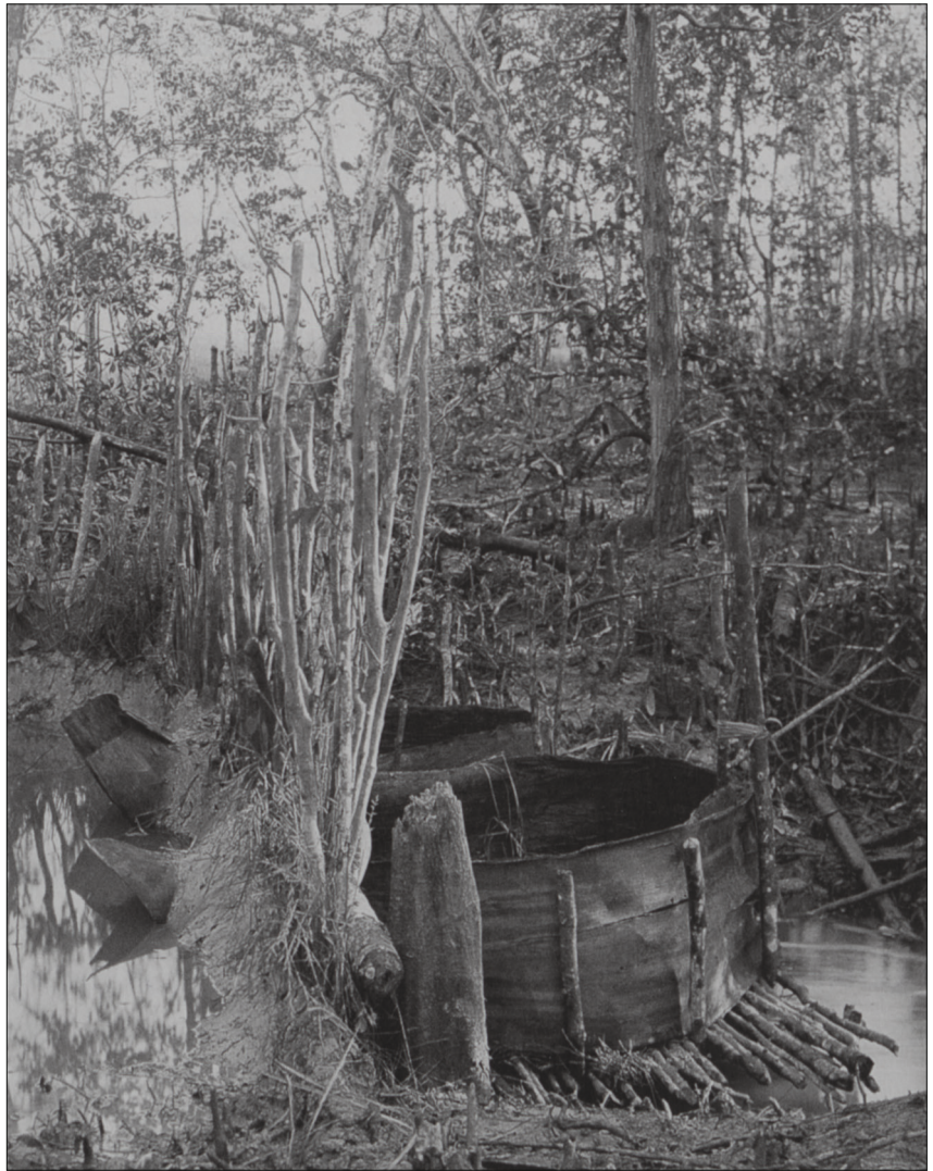
Abb. 15 Nach dem Bau eines Fischwehrs werden Trichter eingesetzt und auf der stromabwärts gelegenen Seite eine Plattform mit einem Rindengehege zum Auffangen der Fische errichtet (Arnhem Land).
