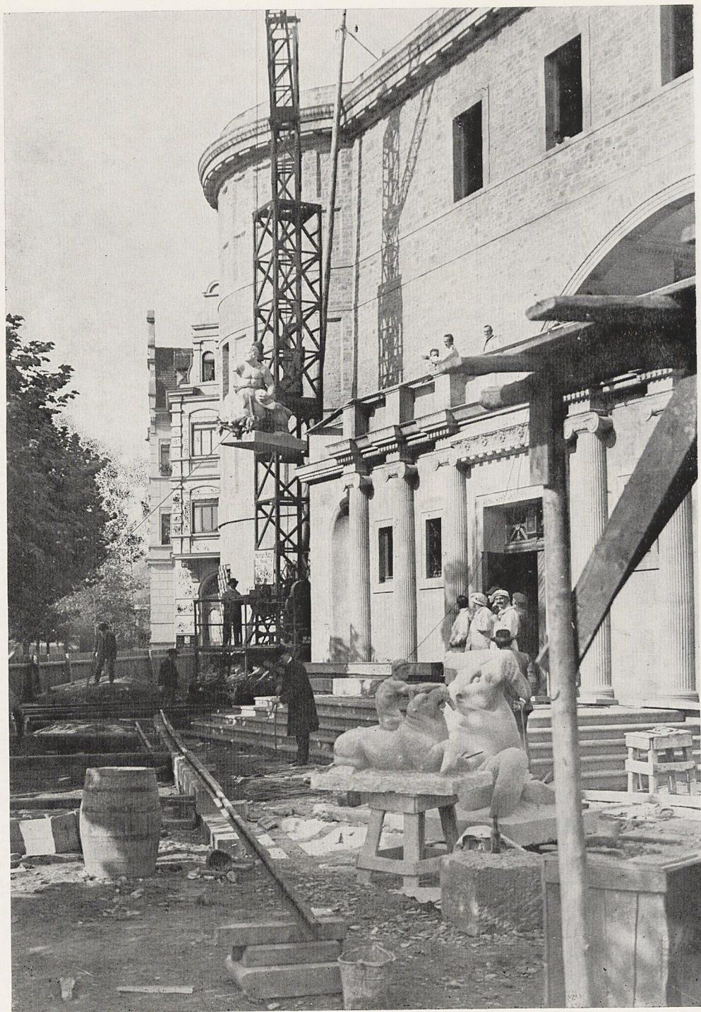
Taf. 19. Bau des Provinzialmuseums 1913, Aufzug der Figuren auf das Dach
