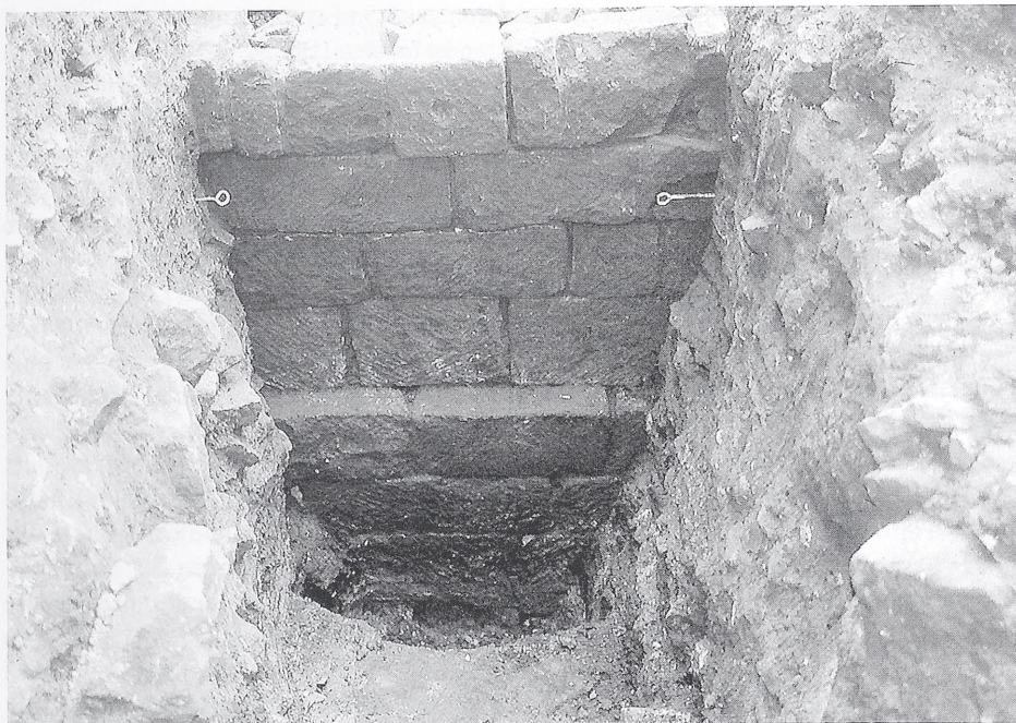
Abb. 7: Weißenfels, Schloß. Trockenmauer aus sorgfältig behauenen Sandsteinquadern (Befund 333) von Westen
