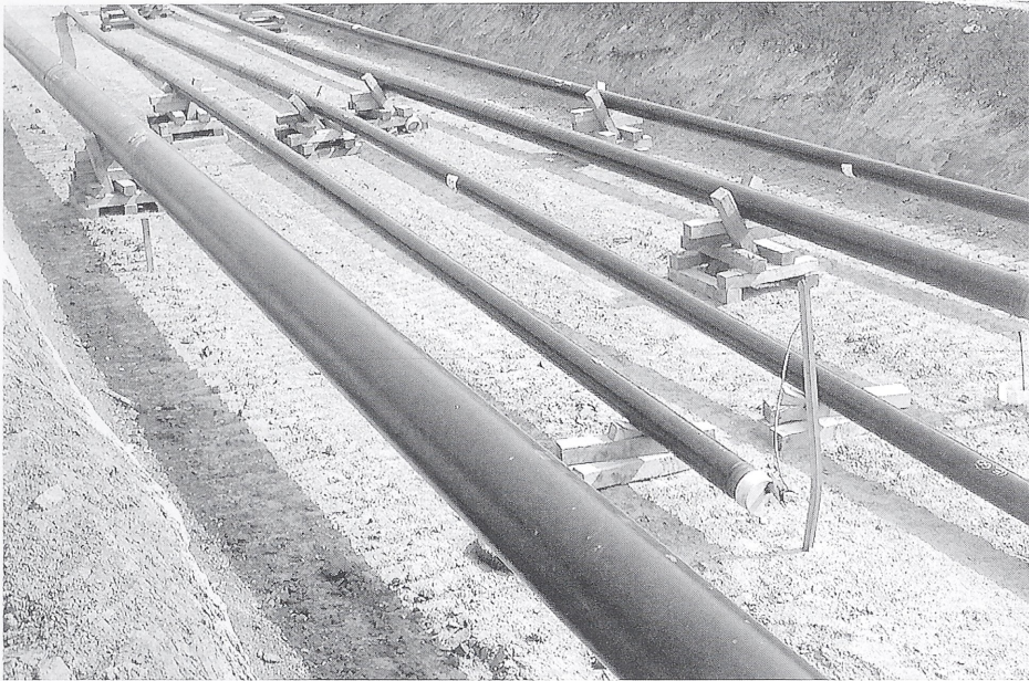
Abb. 2: Verlegung von fünf Rohrleitungssträngen in Baulos 1 bei Röcken, Ldkr. Weißenfels
