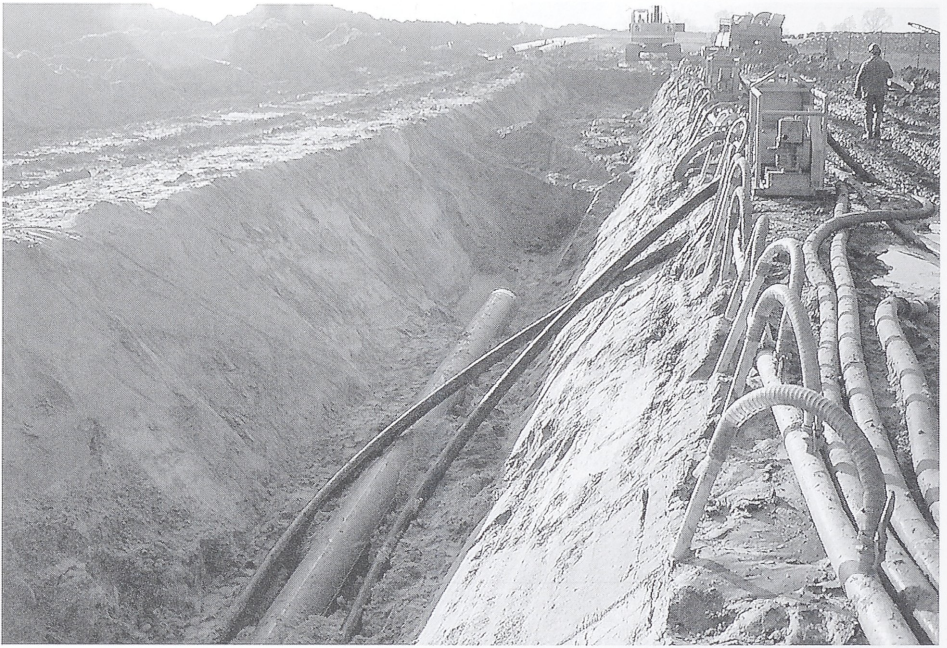
Abb. 5: Rohrgraben in Baulos 3 bei Groß Holzhausen, Ldkr. Stendal, mit Wasserhaltung zur Grundwasserabsenkung und bereits abgesenktem Rohrleitungsstrang
