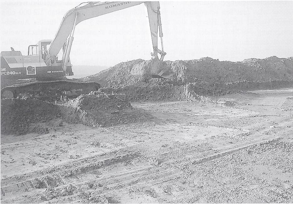
Abb. 1: Abzug des „Mutterbodens“ mit dem Bagger bei Losse, Ldkr. Stendal
