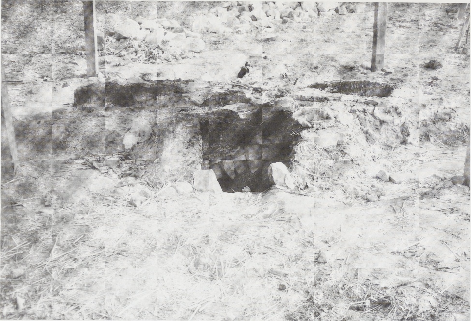
Abb. 6: Rüdersdorfer Ofen nach dem Brand mit intaktem Kalksteingewölbe
