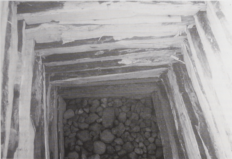
Taf. 5b: Klötze, Altmarkkreis Salzwedel. Brunnenrekonstruktion Langobardenwerkstatt Zethlingen: innerer Brunnenschacht 1993
