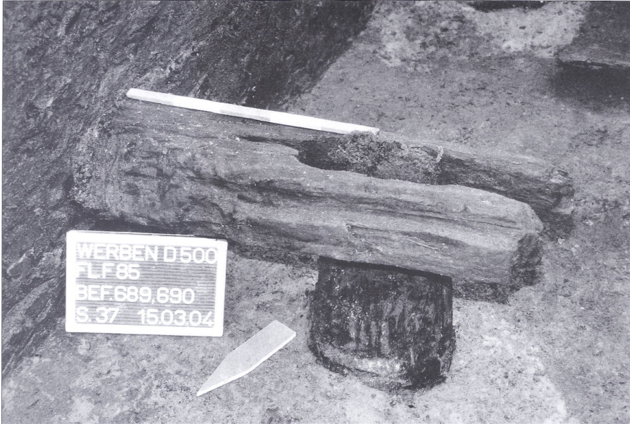
Abb. 11 Schnitt 37: Brückenpfeiler (um/nach 1184) und Trägerbalken (1188).
