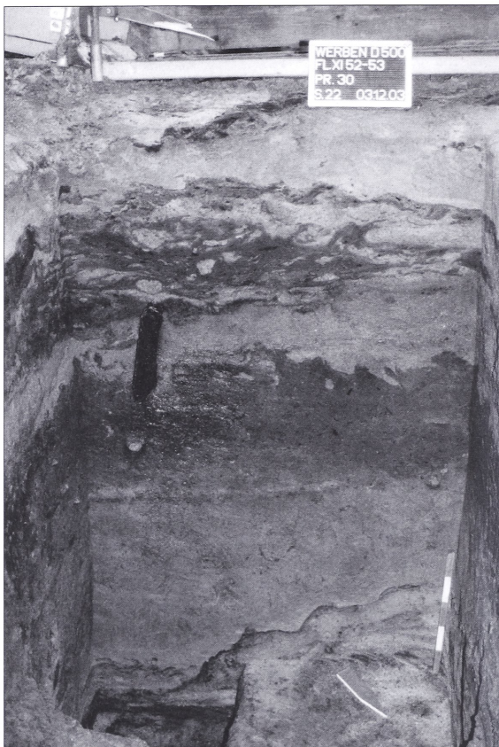
Abb. 32 Leitungsgaben vor Seehäuser Str. Nr. 6: Schichtaufbau im Profil.
