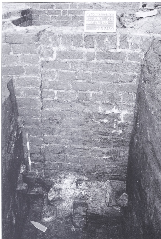
Abb. 19 Ansicht der westlichen Mauer- schale der Grabenfuttermauer mit Blickrichtung vom Graben aus.
