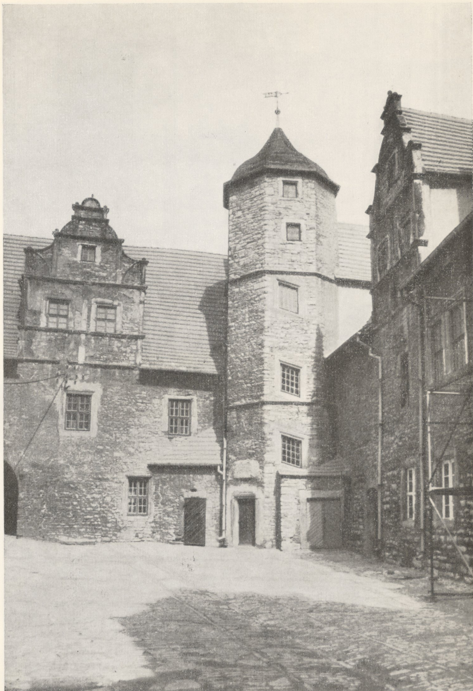
Taf. 1. Plötzkau, Kr. Bernburg. Blick vom Innenhof auf den Nordtrakt des Renaissanceschlusses, das künftig als Zentraldepot genutzt werden soll
