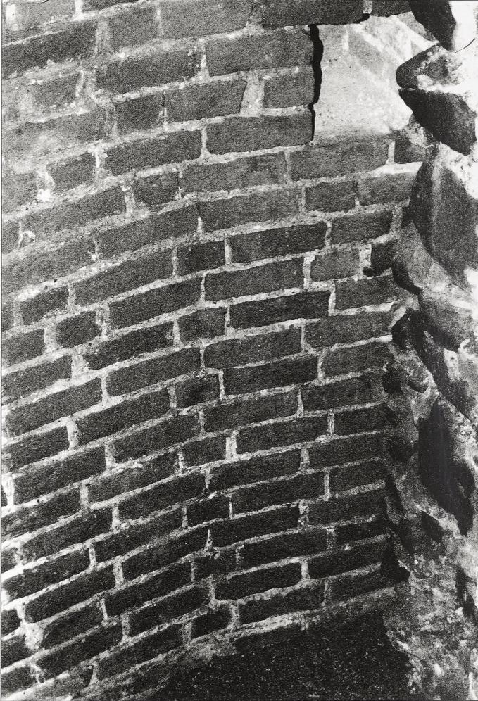
Abb. 4 Jessen, Ldkr. Wittenberg, Schloß. Innenseite der Ringmauer an der Nordseite, rechts anstoßend Mauerwerk des 15. Jh., oben Balkenloch für Kragbalken eines Wehr-ganges.
