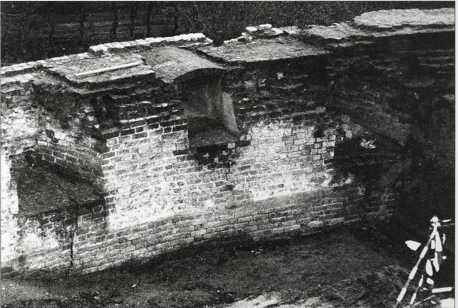
Abb. 6 Jessen, Ldkr. Wittenberg, Schloß. Teilansicht der Ringmauer im Osten der Burg mit zwei primären Schlitzfenstern, Balkenlöchern für Kragbalken und einem sekundär eingebrochenem Fenster (Mitte).
