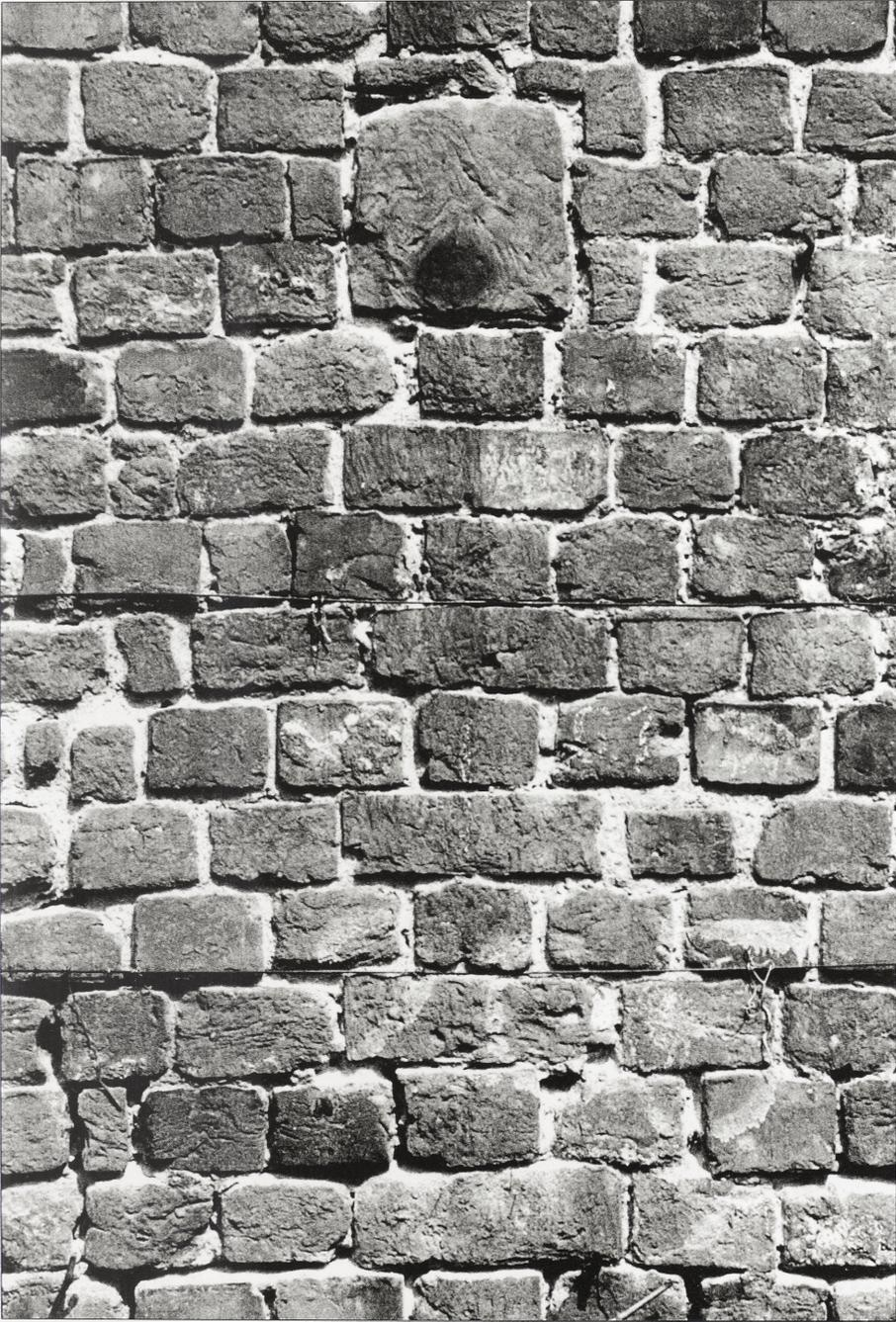
Abb. 5 Jessen, Ldkr. Wittenberg, Schloß. Mauerverband an der Außenseite der Ringmauer mit quaderförmigem Sandsteinbinder.
