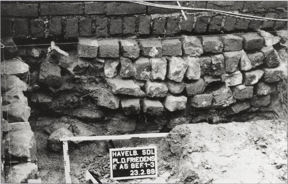
Abb. 8 Havelberg, Ldkr. Stendal, Platz des Friedens, Schnitt A-5. Blick auf das Fundament der Südwand des Krugtornebengebäudes von Süden. Links Fundamentoberkante der Dombezirksmauer.
