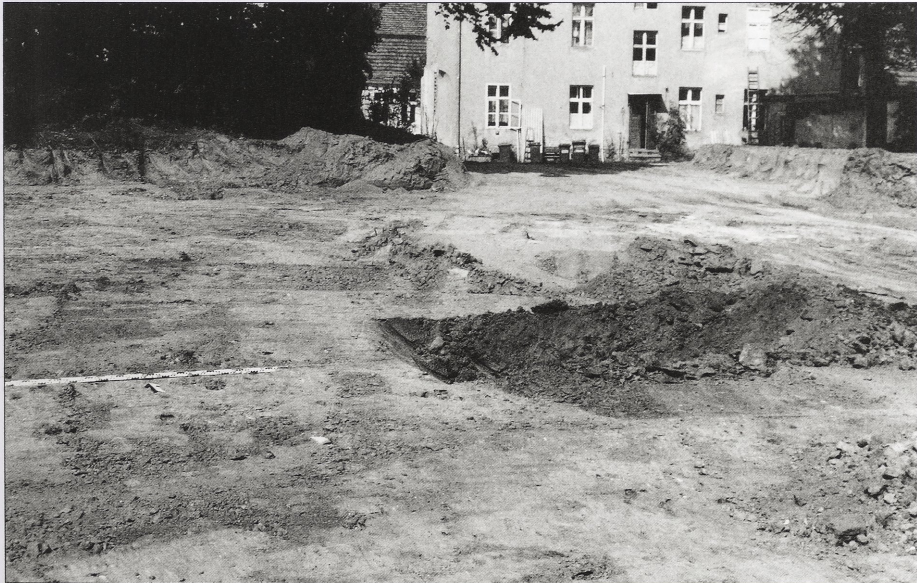
Abb. 20 Havelberg, Ldkr. Stendal. Gelände des zukünftigen Betriebshofes der Stadtwerke hinter dem Gebäude Platz des Friedens 10. Ansicht von Südwesten. Nach dem ersten, flächigen Erdabtrag (eine weitere Eintiefung erfolgte für die neu zu errichtenden Gebäude).
