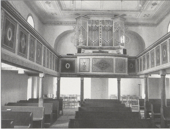
Abb. 7 Kirche von Axien, Ldkr. Wittenberg. Inneres nach Westen, in Emporenhöhe die zugesetzten Bögen der Doppelarkade.
