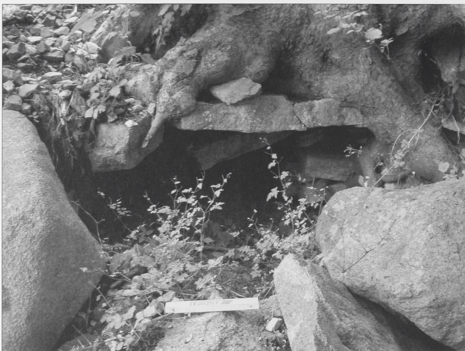
Abb. 17 Gesetztes Mauerwerk eines Steinkanal im Südosten des Klosters Ilsenburg.
