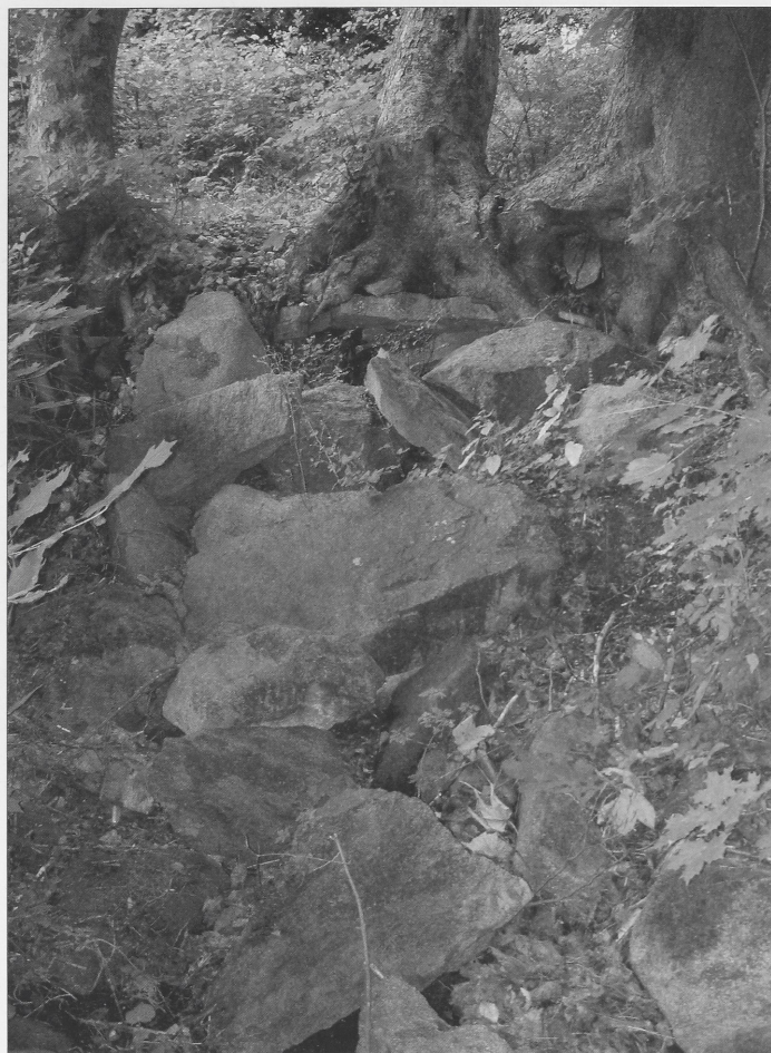
Abb. 18 Steinkanal im Südosten des Klosters Ilsenburg.
