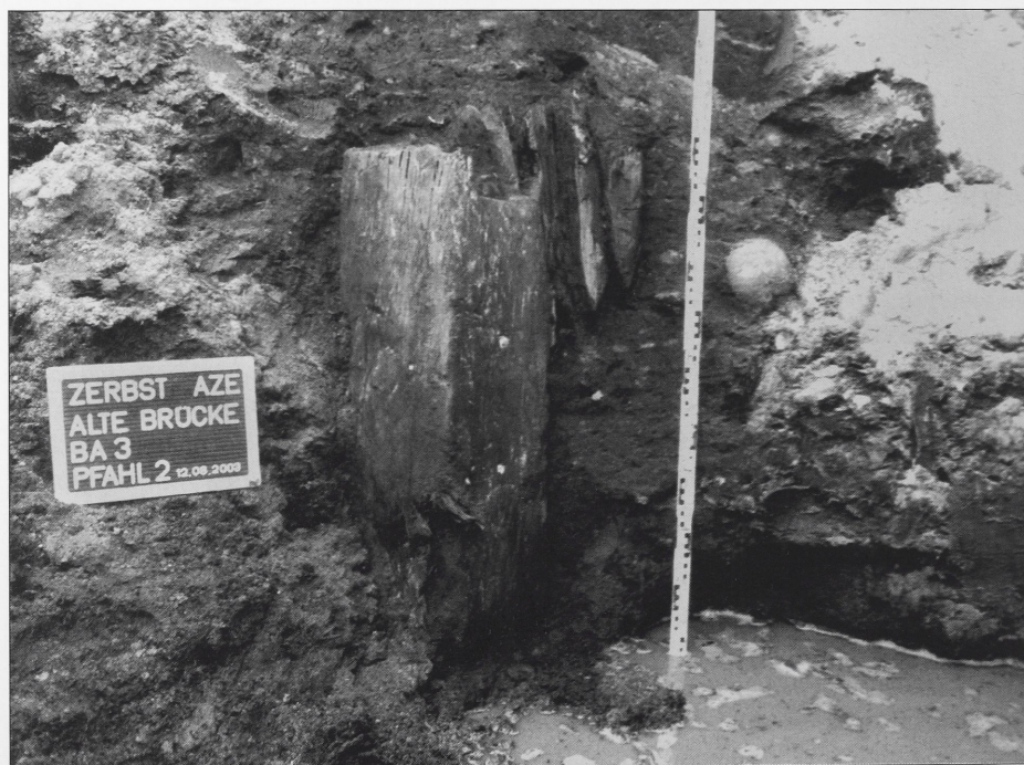
Abb. 11 Zerst, Ldkr. Anhalt-Bitterfeld. »Alte Brücke«. »Pfahl« 2 in sekundärer Verbauung, darüber später eingeschlagene Erlenpflöcke.
