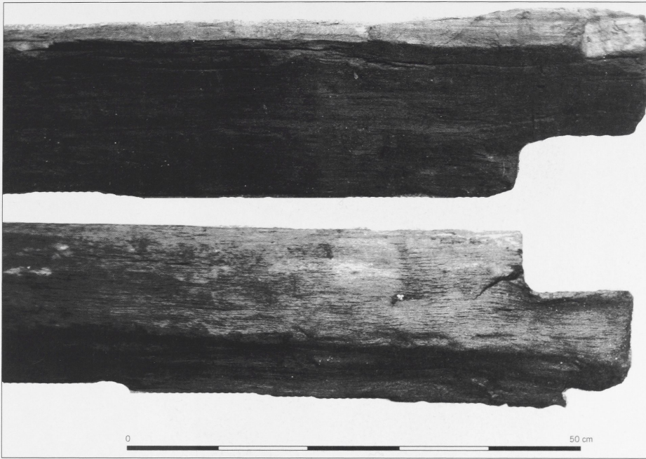
Abb. 18 Zerbst, Ldkr. Anhalt-Bitterfeld. »Alte Brücke«. Das in »Pfahl« 6 eingezapfte Ende des Schwellbalkens.
