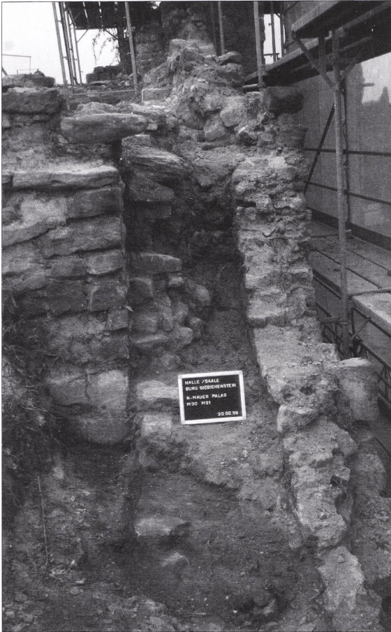
Abb. 22 Palas, Raum V – Blick in die abgebrochene Nordaußenmauer nach Westen. Links anstoßend die mehrphasige Trennmauer der Räume IV und V.
