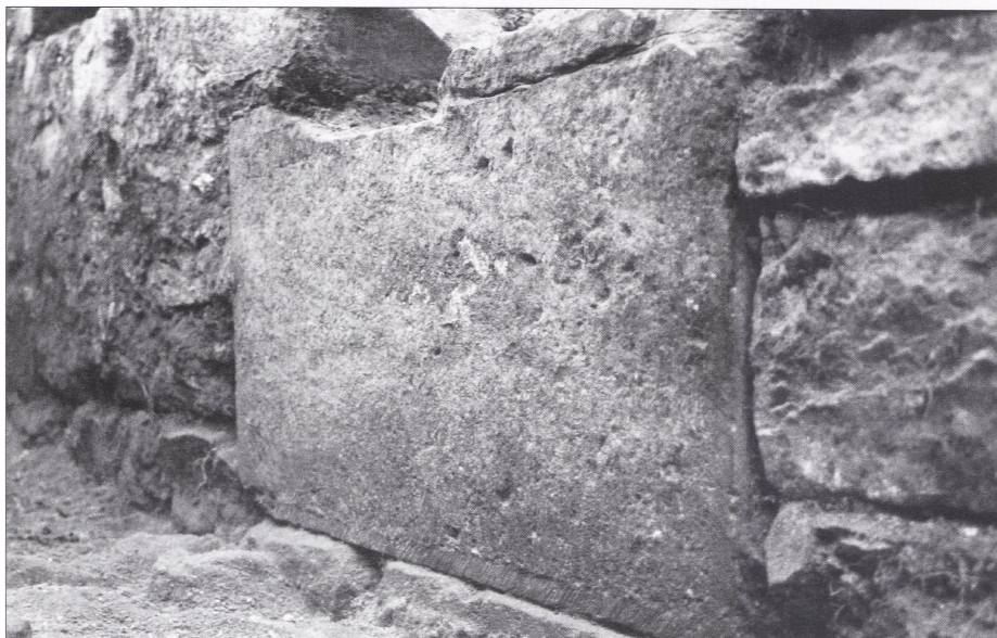
Abb. 6 Schnitt A, Wohnturm – Oberster originaler Eckquader mit Randschlag.
