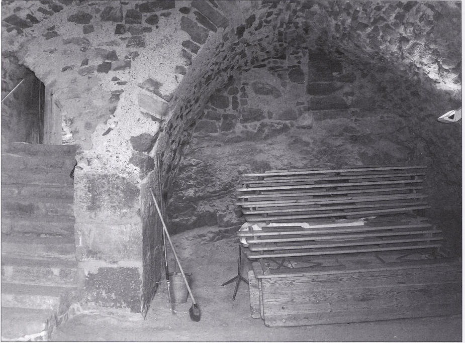
Abb. 23 Gewölbe II – Blick nach Norden auf den zugesetzten Eingang (unter dem jüngeren Gewölbescheitel).
