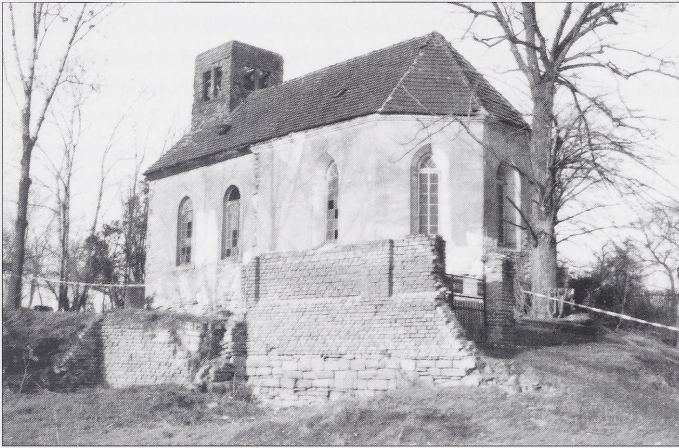
Abb. 4 Schwerzau, Burgenlandkreis. Kirche von Südosten: Romanischer Saal (13. Jh.) mit barocken Rundbogenfenstern (Anfang 18. Jh.) und gotischem Chor (Dendrodatum 1516).
