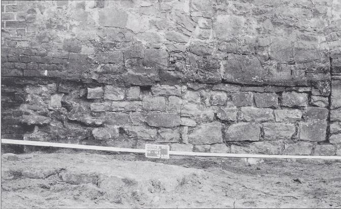
**Abb. 17** Havelberg, Ldkr. Stendal. Dom. Vermauertes Portal in der Seitenschiffnordwand unter dem zweiten Fenster von Osten; vorne links Fundament des Kapellenanbaus
