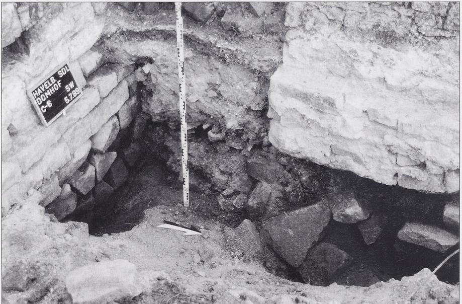
Abb. 21 Havelberg, Ldkr. Stendal. Dom. Winkel zwischen nördlicher Chorseitenkapelle und Eulenturm. Fundamentsondierung an der romanischen Chorseitenkapelle (links) und des gotischen Eulenturms (rechts)
