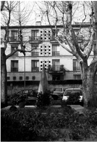
1 Les deux cents logements in Aix-en-Provence
