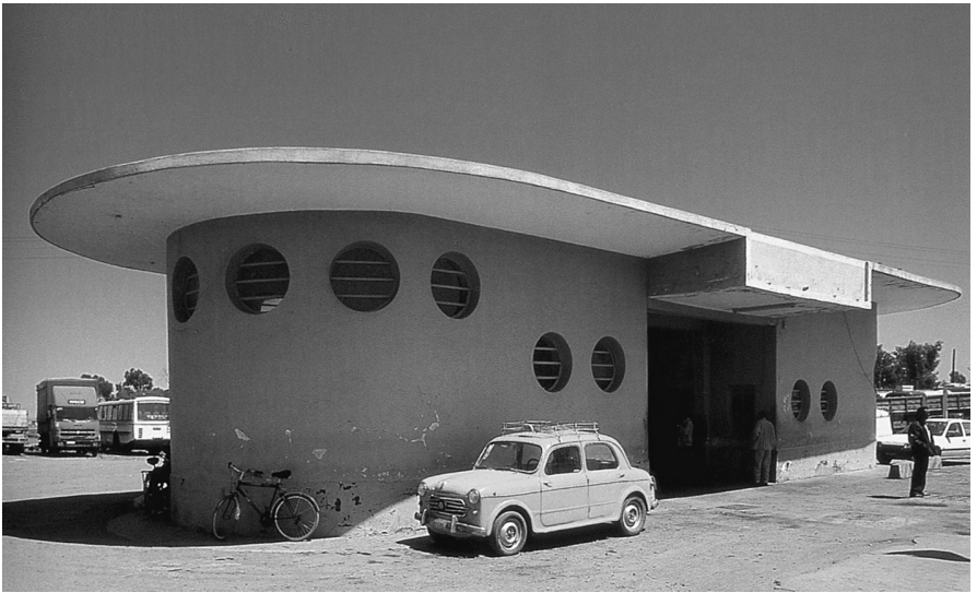
4 Unbekannter Architekt: Asmara, Tankstelle (um 1936).
