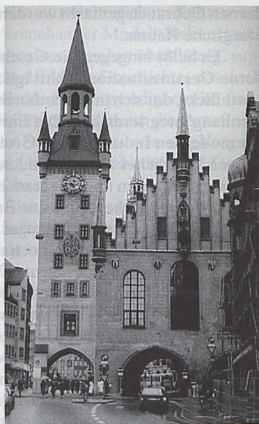
7 München, Rathausturm, Rekonstruktion von 1975.
