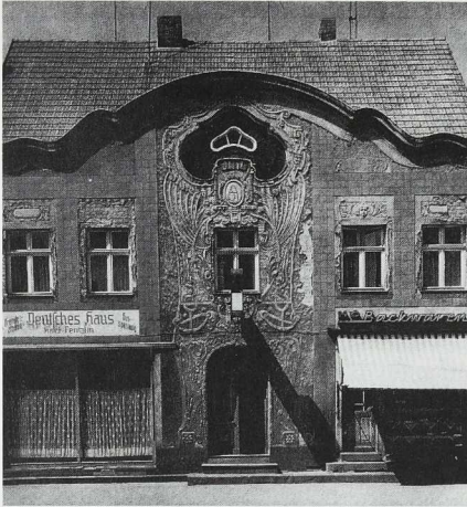
1 Neustrelitz, Gasthof »Deutsches Haus«, nach Umbau 1905, W. Hüttner
