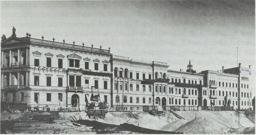
Berlin: Ausgeschlachtete Häuser im Spreebogen vor ihrem Abbruch, um Platz für die „große Halle“ zu schaffen.
