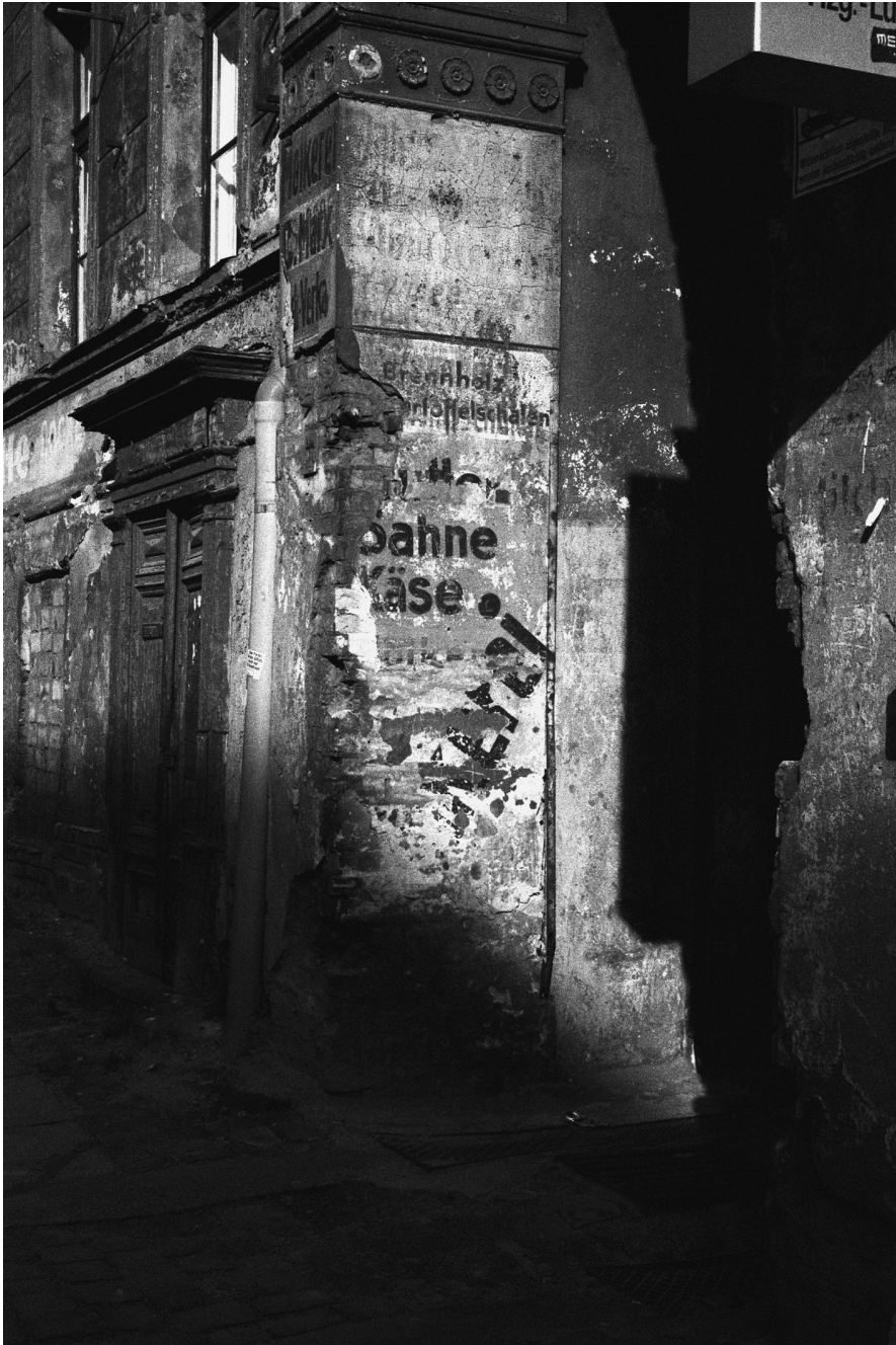
Choriner Straße, Berlin, Mitte 90er Jahre. Das Haus ist inzwischen saniert. Foto: Andreas Trogisch
