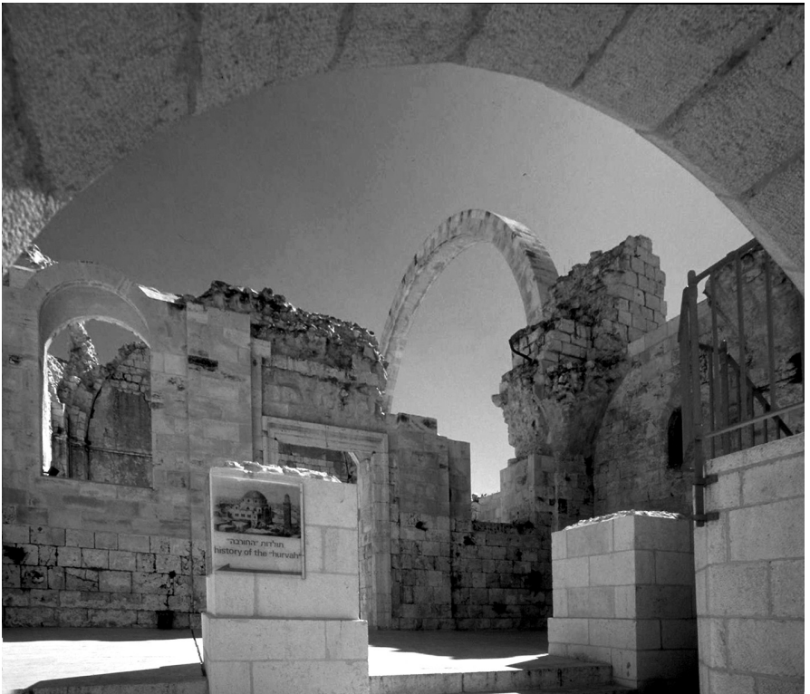
10 Hurva-Synagoge, Jerusalem, Sicherung der Ruine und Rekonstruktion eines Entlastungsbogens, 1970er Jahre
