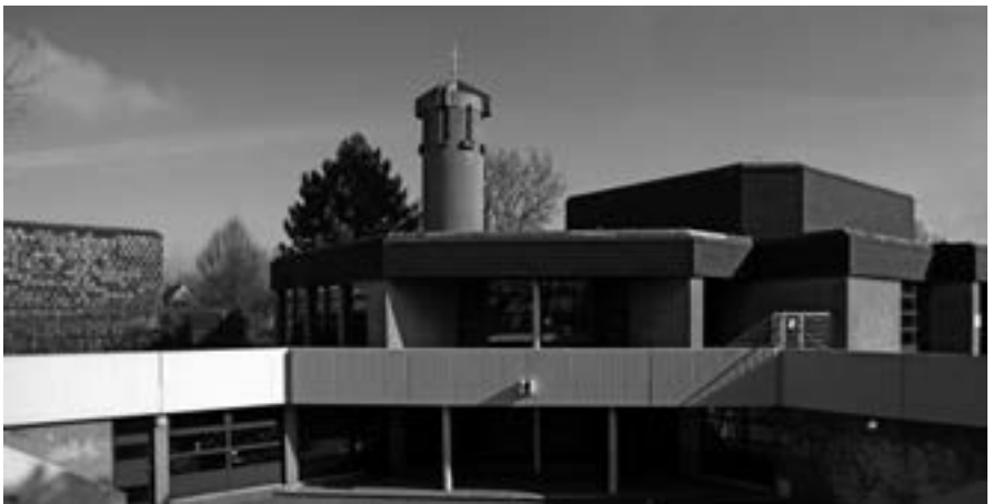
2 Brand&Fiedler, ehemaliges Gemeindezentrum Ev. Matthiaskirche in Düsseldorf, um 1970, Fotografie 2015.
