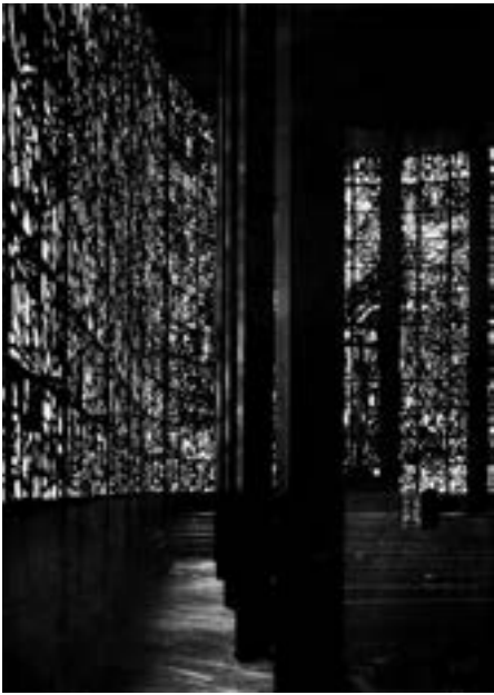
1 Otto Bartning, Stahlkirche auf der Pres- sa-Ausstellung 1928 in Köln (nach der Ausstel- lung in Essen neu aufgebaut), Fotografie 1928.
