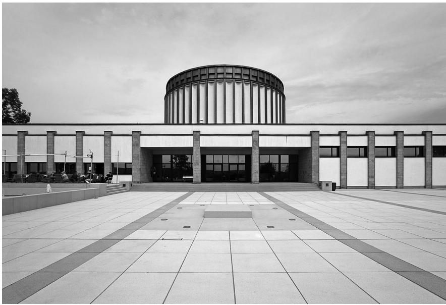
5 Herbert Müller: Panoramamuseum Bad Frankenhausen, 1976–1987, Frontalansicht.
