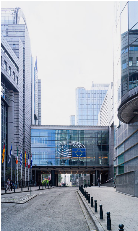
3 Brückenbau zwischen Alterio-Spinelli und Paul-Henri-Spaak-Gebäude, 2020, Brüssel
