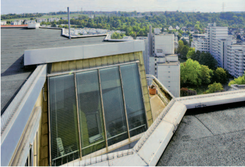
Abb. 5 Büro Scharoun & Co., Wohnhochhausgruppe „Romeo und Julia“, Stuttgart-Zuffenhausen, 1954–59. Dachdetail (Bock, S. 260)
