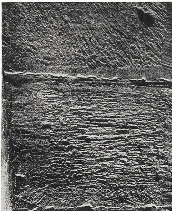
Abb. 4c Speyer, Dom. Quader von einem Mittelschiffsgurtbogen mit geflächtigem Spiegel und Randschlag (Bau II)
