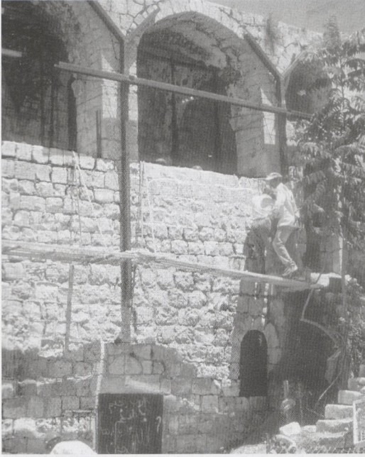
Abb. 3 Osmanischer Gerichtshaus, Ramallah, während der Restaurierungsarbeiten 2002/03 (Riwaq)
