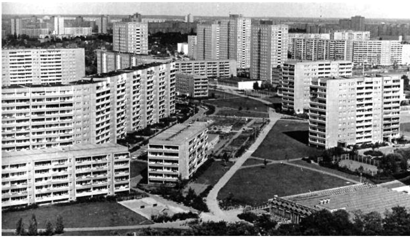
Abb. 2 Blick über den nördlichen Teil des Wohngebiets 1 in Marzahn mit seinen großformatigen Plattenbauten (Braun 2019, Abb. 50, S. 97)
