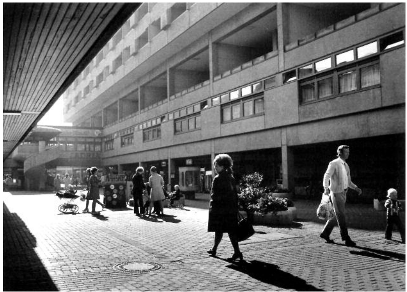
Abb. 3 Blick in das Passagen- und Gassensystem, das dem Märkischen Zentrum nach der Fertigstellung den Beinamen Basar einbrachte (Braun 2019, Abb. 141, S. 306)
