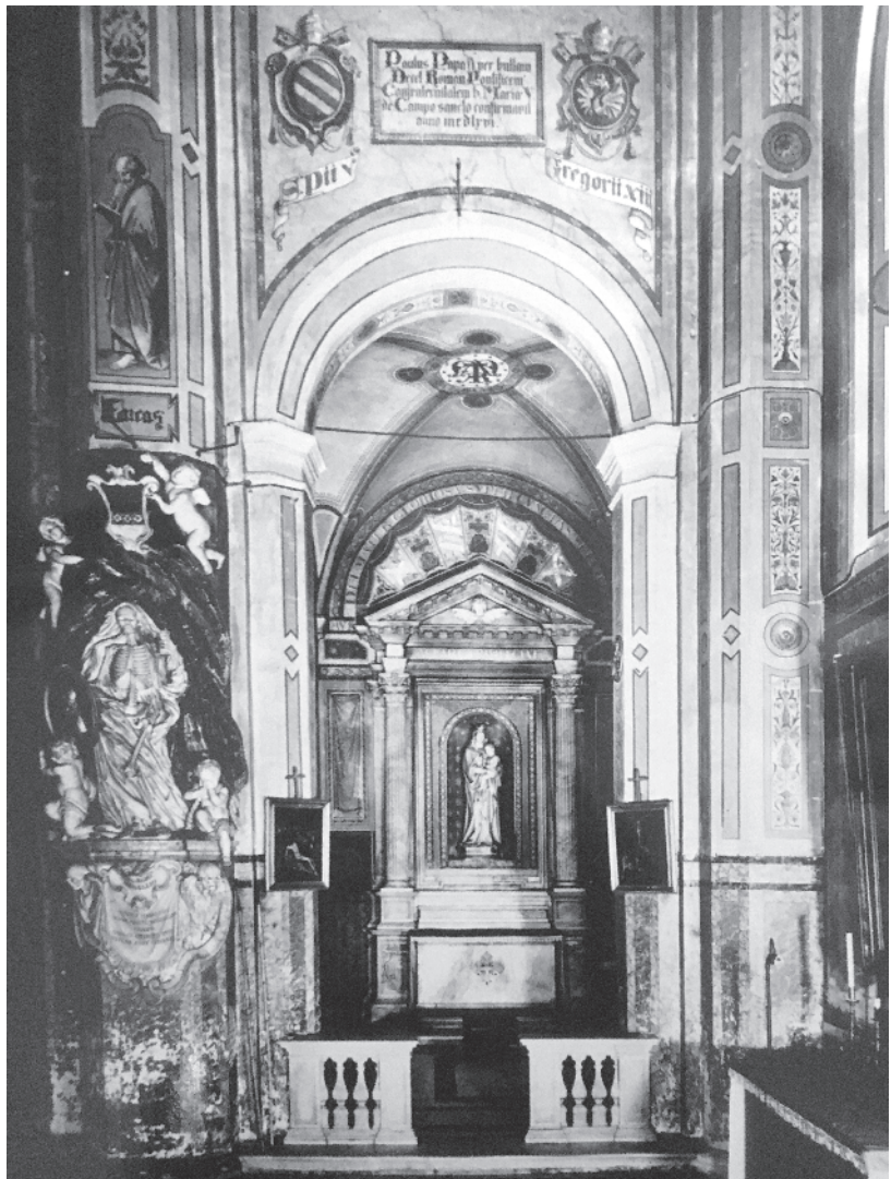
Abb. 2 Erasmuskapelle, S. Maria della Pietà, Campo Santo Teutonico, Rom (Foto vor der Restaurierung 1975, Archiv Campo Santo Teutonico)
