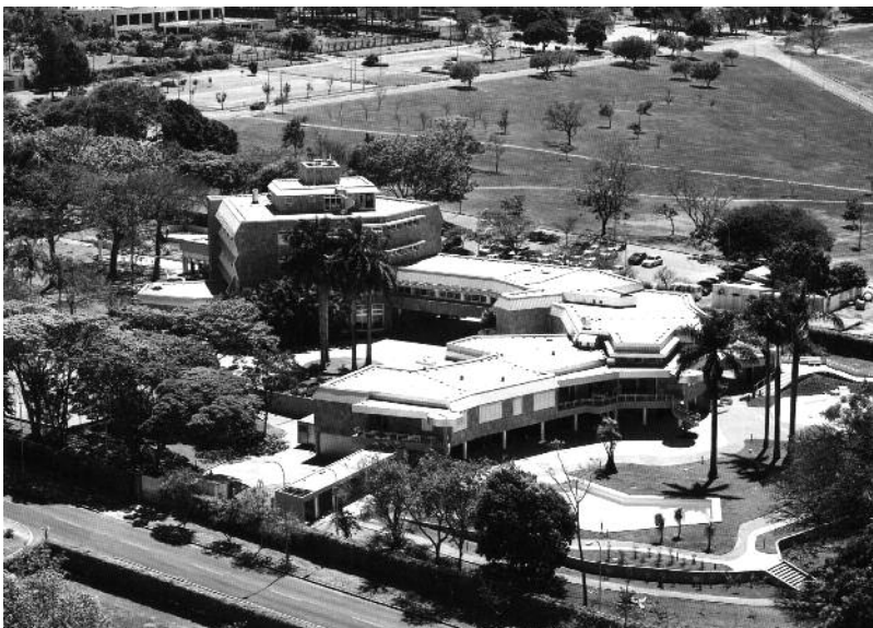
Abb. 2 Hans Scharoun, Deutsche Botschaft Brasília (Kanzlei und Residenz), 1968–71. Gesamtkomplex mit der Residenz im Vordergrund (Archiv BBR, 2007; Plessen, S. 184)
