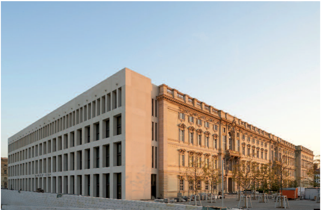
Abb. 6 Humboldt-Forum Berlin, Ost- und Nordfassade (© Stiftung Humboldt Forum im Berliner Schloss / Architekt: Franco Stella / Foto: Alexander Schippel)
