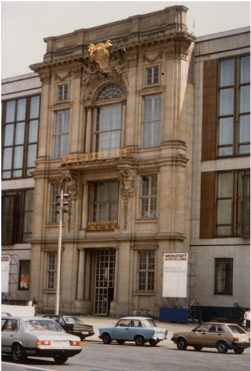
Abb. 3 Berlin: Ehemaliges Gebäude des Staatsrates der DDR, mit vorgeblendetem Portal IV des Schlosses, Aufnahme 1993 (Foto: M. F. Fischer)
