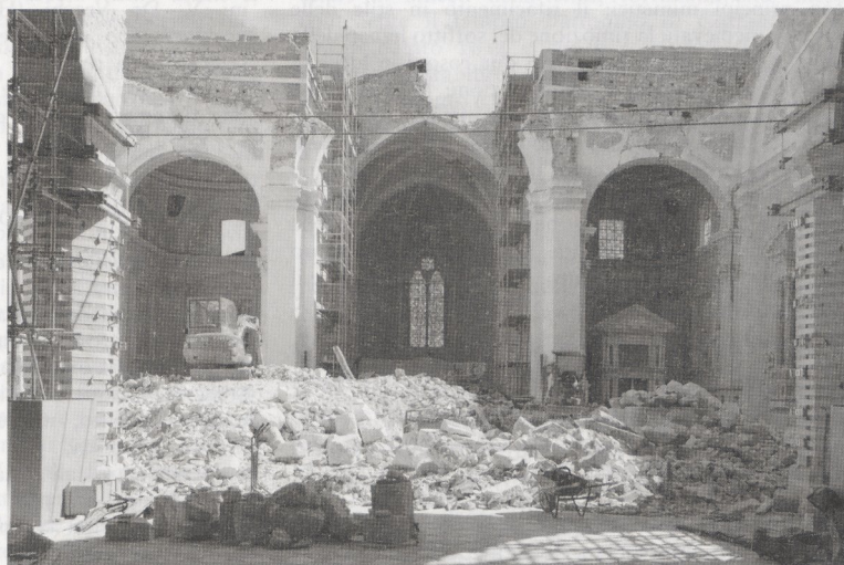
Fig. 10 L'Aquila, S. Maria di Collemaggio, transetto crollato e coro, 2009 (A. Thielemann)
