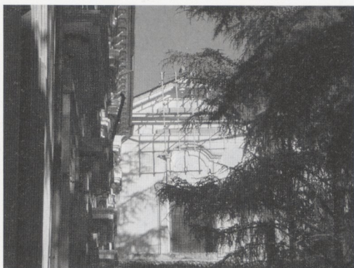
Fig. 13a L'Aquila, convento di S. Basilio, facciata della chiesa, 2009 (D. Del Pesco)
