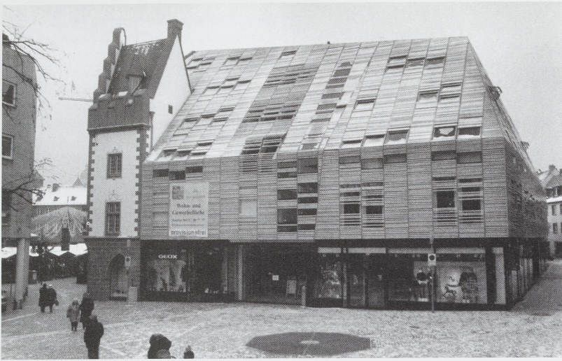
Abb. 3 Massimiliano Fuksas, Mainzer Einkaufszentrum mit wiederhergestellter Markthäuserfassade, 2007-2009 (Kat. S. 459)
