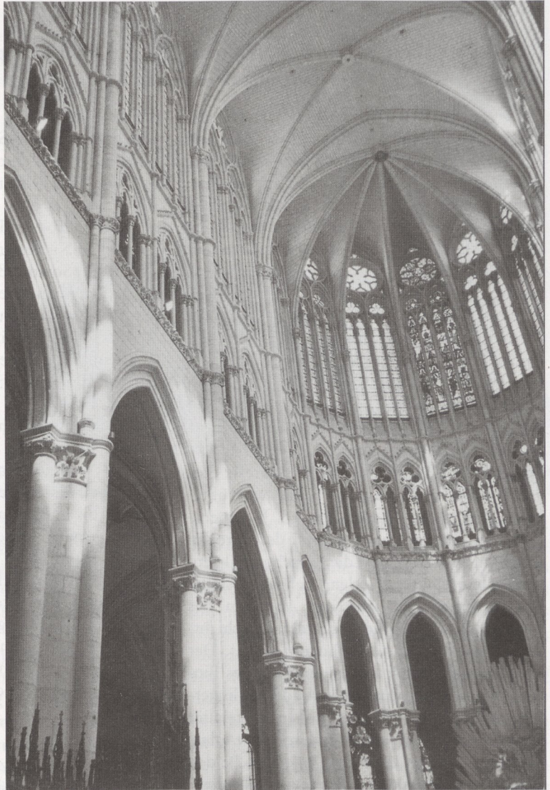
Abb. 6 Amiens, Kathedrale, Hochchor nach kompletter steinsichtiger Freilegung, Zustand 2005, bei strahlender Sonne und Scheinwerfer- beleuchtung (Autor)
