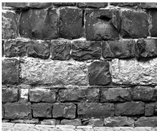
Abb. 5 Aachen, Rathaus, Westapsis (Marienturm). Mauerwerk ( opus vittatum ) im Bodenbereich (Archiv des Autors)
