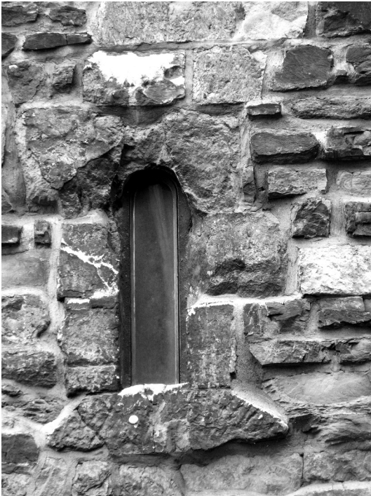
Abb. 3 Aachen, Rathaus, Granusturm, Fenstereinfassung aus unbearbeiteten Steinen, Detail (Archiv des Autors)
