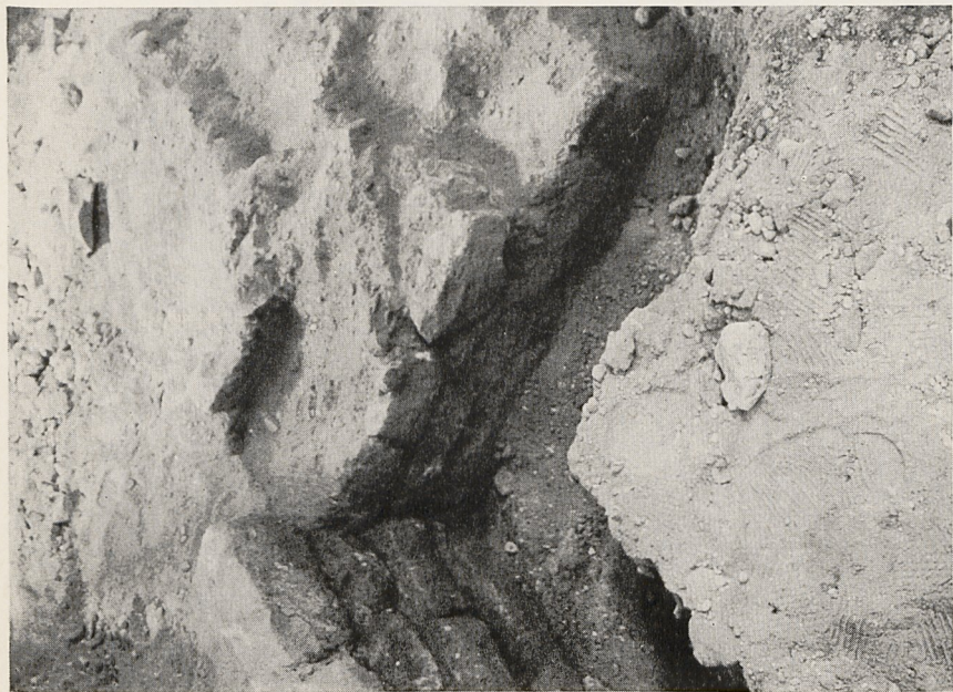
Abb. 3a Speyer, Dom: Südl. Seitenschiff, Ansatz des Westmauerfundaments (rechts) im 3. Joch, 1963 (Foto: F. Klimm, Speyer)
