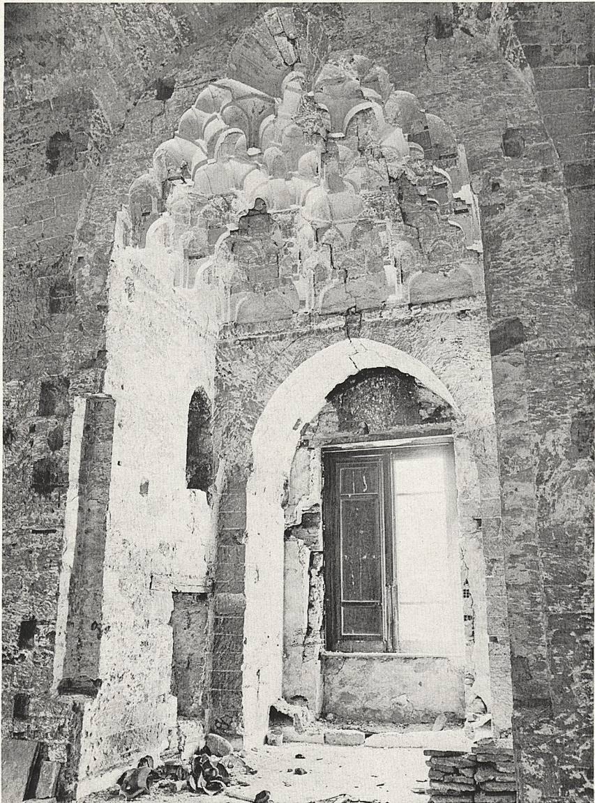
Abb. 4 Palermo, Zisa. Stalaktitengewölbe im Obergeschoß
