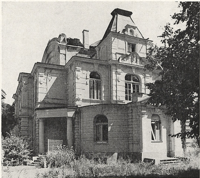
Abb. 2b Göggingen, Kurhaustheater, Außenansicht, Zustand nach dem Brand 1972
