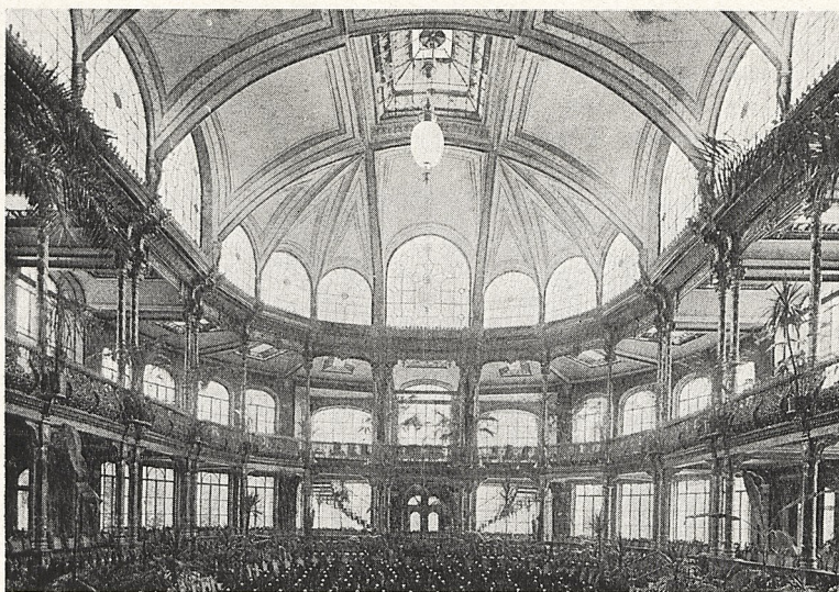
Abb. 3a Göggingen, Kurhaustheater, Innenansicht, alter Zustand
