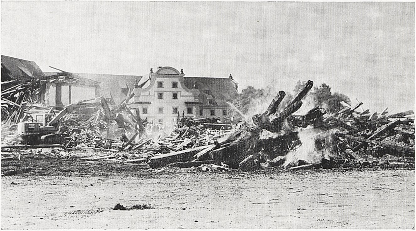
Abb. 1a Weingarten, Kloster, Blick über die eben abgebrochenen Ökonomiegebäude auf den Fruchtkasten (Sommer 1973)
