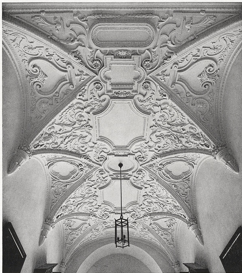
Abb. 1 München, Residenz, Eingangsraum der Trierzimmer (Raum Nr. 45e; alte Nr. 29), Stuckdecke
