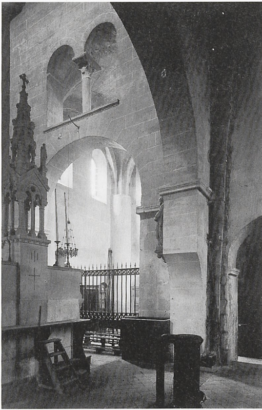
Abb. 14 Perrecy-les-Forges/Saône-et-Loire, Prioratskirche, Inneres, Blick vom Chor auf die nördl. Langhauswand (Marburg 41971)
