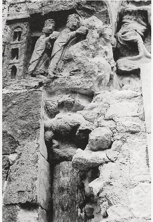
Abb. 3 Chassenard/Allier, Kirche, Seitenportal, Detail, 2000 aufgedeckt (Autor)
