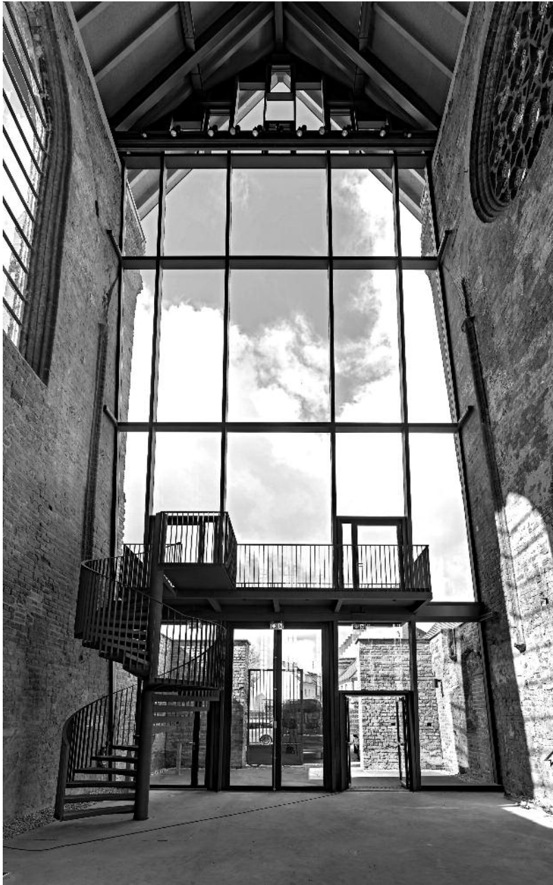
Abb. 3 Brandenburg an der Havel, ehem. Klosterkirche St. Johannis, Hauptschiff, neue Westfassade, Aufnahme 2015 (Foto: Stephan Melchior)
