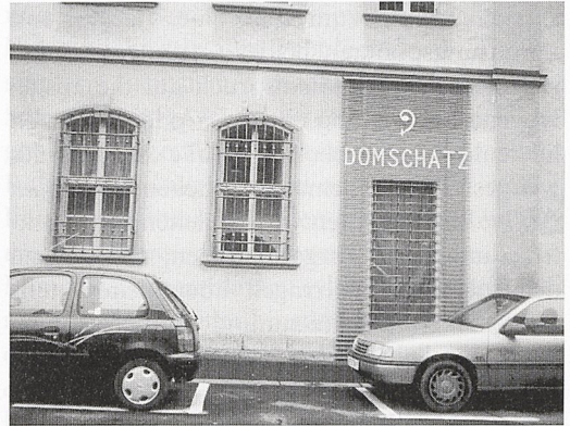
Abb. 3 Würzburg, Marmelsteiner Hof nach der Veränderung von 1999: der neu gebrochene Eingang (Dr. Suse Schmuck)
