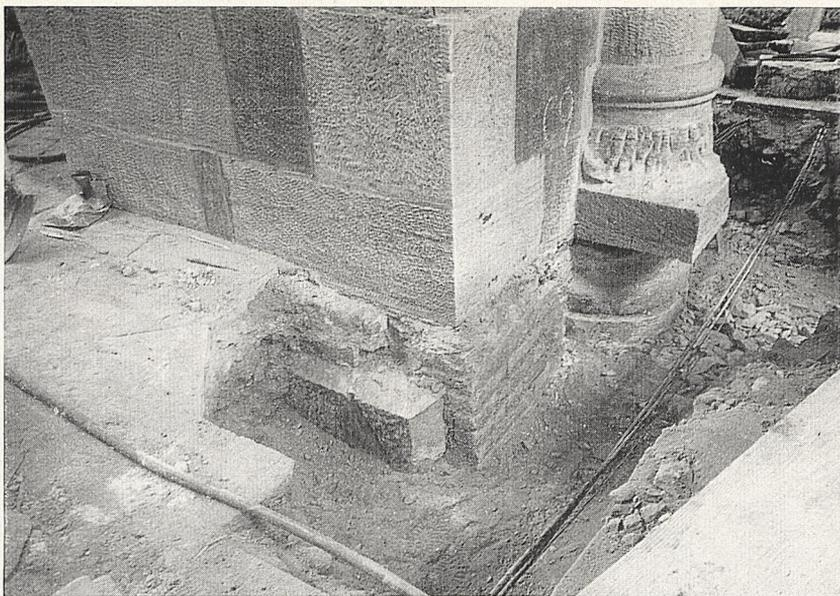
*Abb. 3 a Speyer, Dom. Pfeilerfuß im südl. Seitenschiff mit frühromanischer und 1958 darüber falsch ergänzter Basis*
