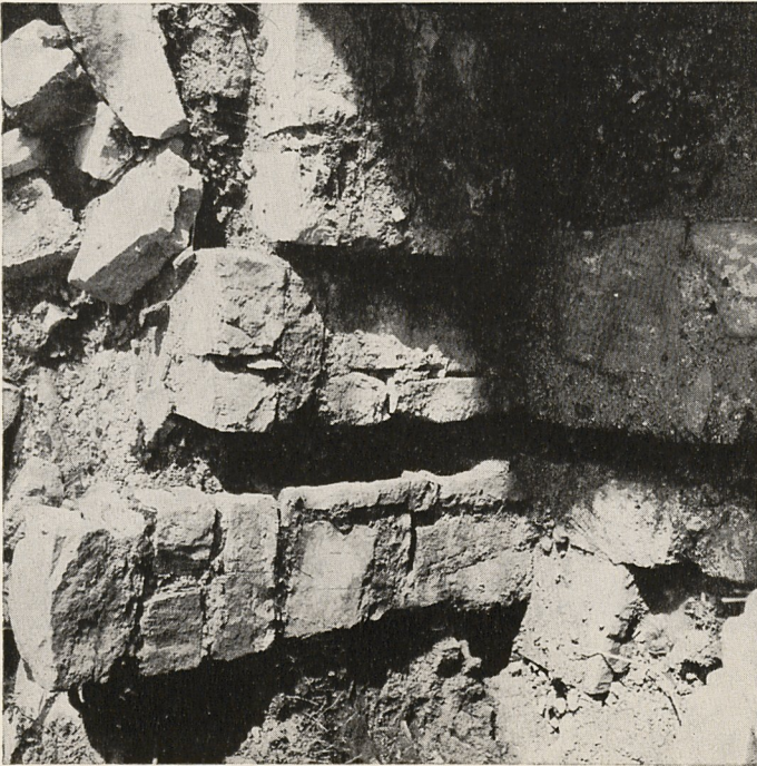
Abb. 3a Helmarshausen, Klosterkirche I. Grabungsbefund: Türgesimse im Nordschiff mit Nuten für Holzrahmen
